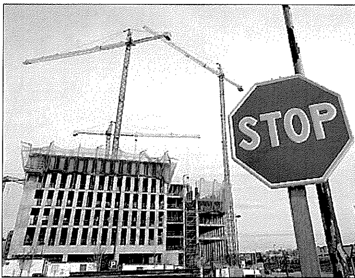
Edificio en construcción en las afueras de Madrid. BLOOMBERG
